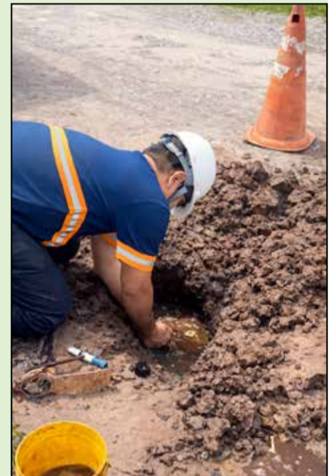
Manutenções em conexões de água
